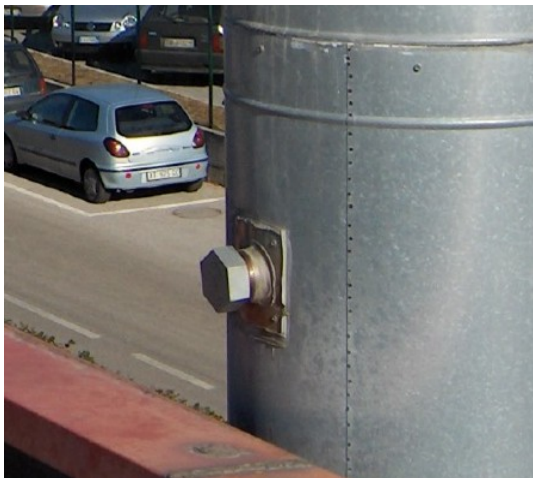
Esempio di tronchetto di prelievo UNICHIM di tipo "A" da 2"½
