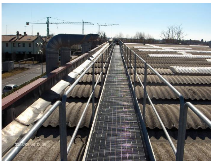
Passerella con regolare parapetto su tetto in “eternit”
